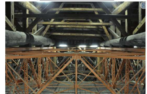
東大寺大仏殿の鉄骨トラス
