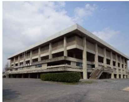
RC 造(屋根 S 造) 体育館
